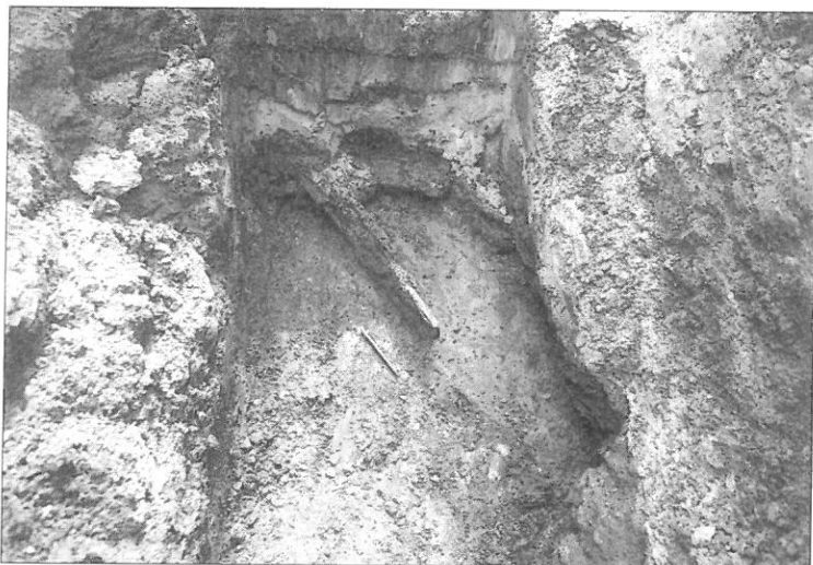
Ilustr. 1. Pozostałości drewnianych instalacji wodociągowych o nieustalonej chronologii, odkrytych w trakcie prac ziemnych związanych z wymianą ciepłociągu na terenie Starego Miasta (ul. Bolesława Chrobrego 13) w Stargardzie w 2002 r. Fot. M. Majewski – Muzeum Stargard
